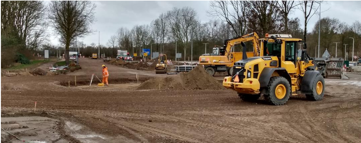
Aanleg fundatie t.b.v. de rotonde
